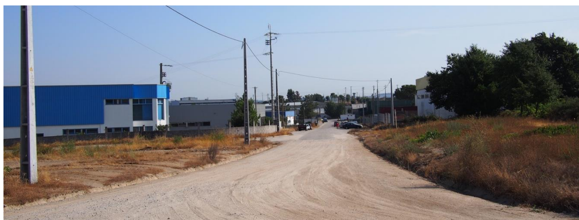
Figura 57: Vista para norte, a partir da via de acesso da ZI, na zona a poente da EM234, sendo possível observar a falta de ordenamento e infraestruturação adequada.
